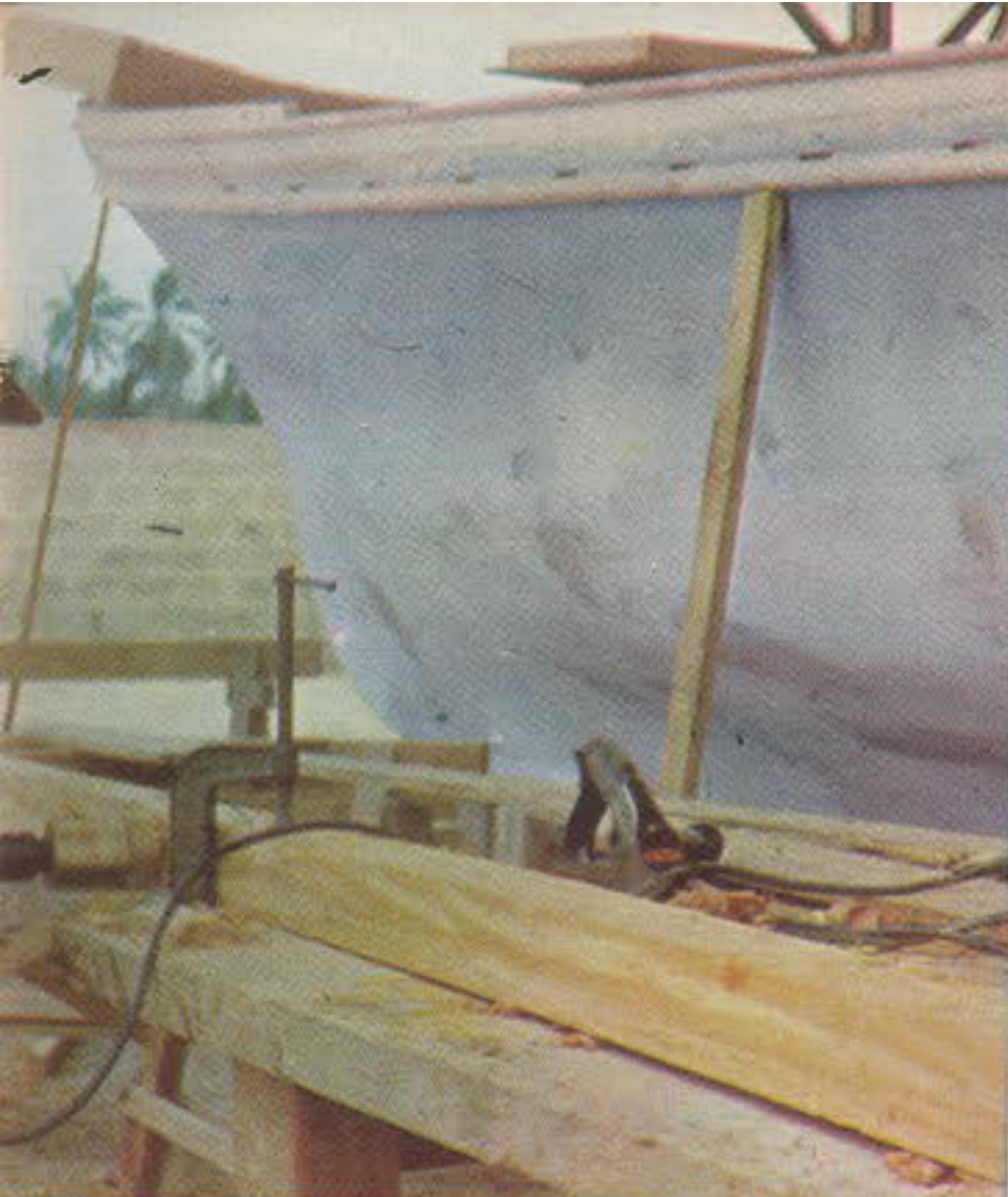
TRABAJAN TANTO EN EL ASTILLERO DE BARCOS TERMINAL PESQUERA.
